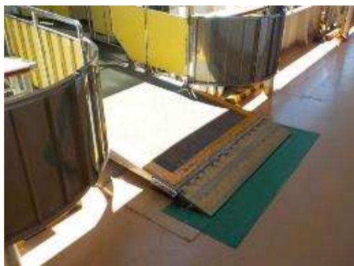
カーフェリー渡船橋への 段差解消スロープ設置
