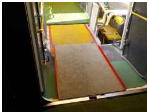
ジェットフォイルタラップへの 段差解消スロープ設置
